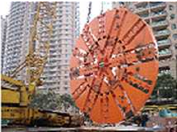
カッタヘッド吊下ろし
