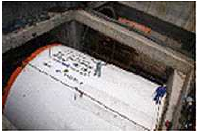
発進立坑での組立
